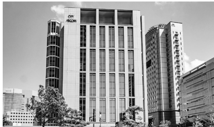
福岡ソフトリサーチパーク地区に1996年完成の本社AITビル
